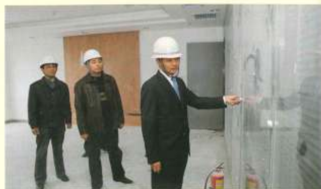
▲ 检查组检查工地施工质量
